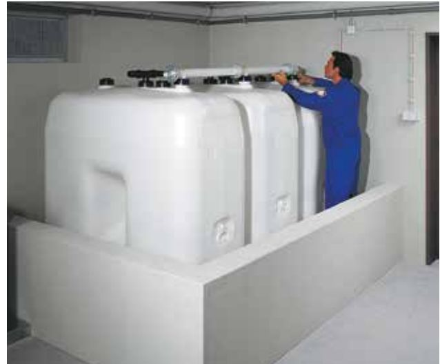
Instalación de los depósitos en un cubeto de obra.
