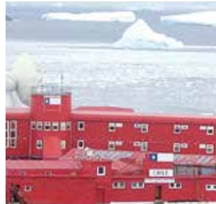
Base militar de la Armada Chilena en la Antártida. Reutilización de aguas grises, depuración de aguas residuales.
